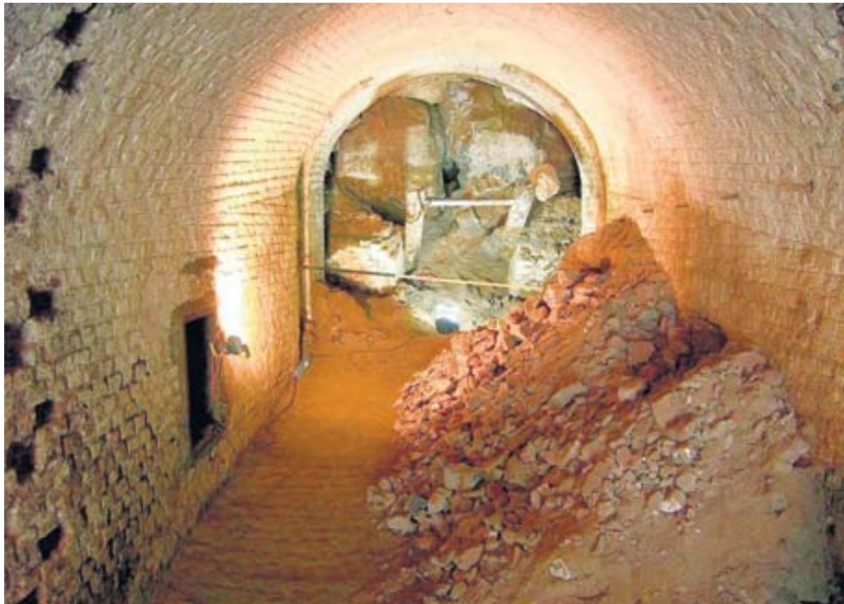
CRIFA-Mitarbeiter legten als jüngstes Projekt den sechs Meter langen, verfallenen Haupttholgang zur gesprengten Spitzkaserne im Zwischenwerk VIII b (Marienburg) frei. Jetzt suchen sie einen Glaser, der die Abdeckung sponsert. FOTOS (2): CRIFA
